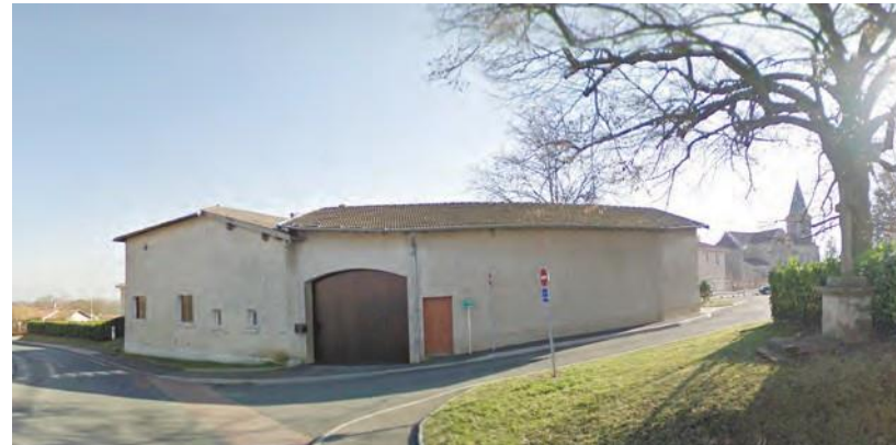
Bâtiment patrimonial à l'angle du chemin de l'église et du chemin du Beaulogis (parcelle n°107)
