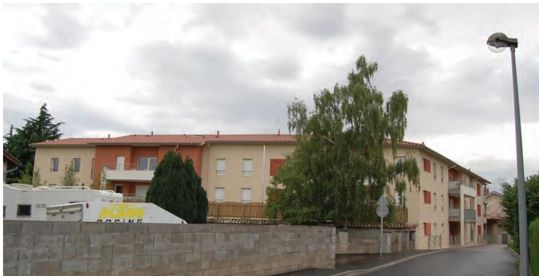
Opération bâtie récente "l'Orangerie"
