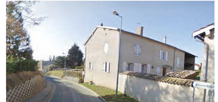
Bâtiment patrimonial chemin du Beaulogis (parcelle n°56)
