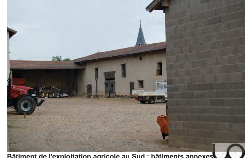
Bâtiment de l'exploitation agricole au Sud : bâtiments annexes
