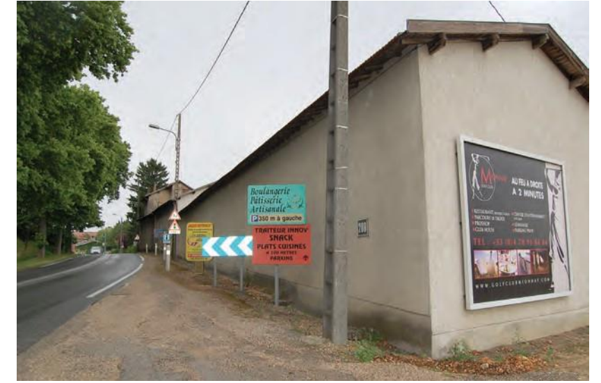
Entrée Sud : publicité, circulation piétonne peu sécurisée
