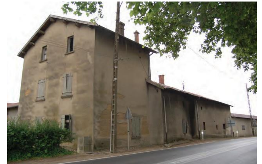
Bâtiment de l'exploitation agricole au Sud : façade sur la RD1083
